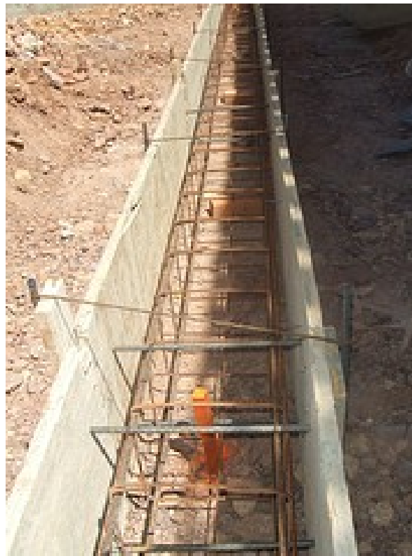
Zapata corrida (armado previo al hormigonado)
