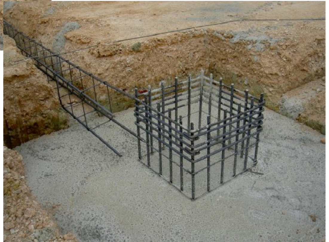
Proceso de hormigonado. Nótese la presencia de vigas de atado / centradoras
