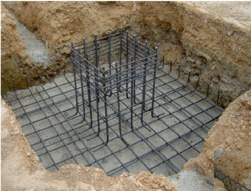
Antes de hormigonar (con suelo preparado)
